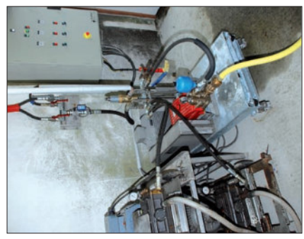
Les trois pompes et le variateur de fréquence.
